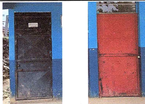
Foto 4: Aplicación de pintura en las diez (10) puertas de los salones de clases.
