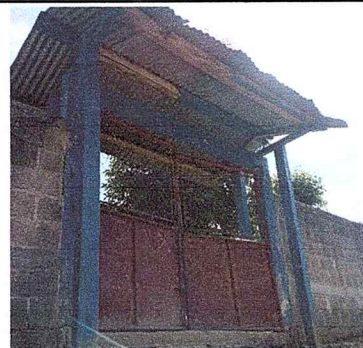
Foto 10: Sustitución de la protección que tiene el portón de la entrada principal, por una estructura de metal.
