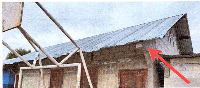
Foto 1: Cambio del entechado en área de cocina, para mejorar las condiciones de la cocina y evitar las goteras. Pintura de la estructura de techo, porque se encuentra en buenas condiciones aún.
