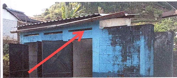
Foto 2: Cambio de entechado de los nueve servicios sanitarios para mejorar las condiciones y evitar el ingreso de agua.
